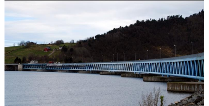
Figur 1. Bergsøysundbrua i Møre og Romsdal, Norge. Längd 931 m, största spann 106 m, seglingsfri höjd 6 m. Färdigställd 1992. Bildkälla: http://gunnarhustad.blogspot.se/search/label/flytebru
