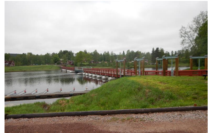
Figur 2. Bro över Österdalälven vid Gagnef, Sverige. Längd 196 m, spann mellan pontoner 4,8 m. Färdigställd 1935. Konstruktionsnummer: 20-384-1. Bildkälla: BaTMan (Trafikverkets förvaltningsystem för broar, tunnlar och byggnadsverk)
